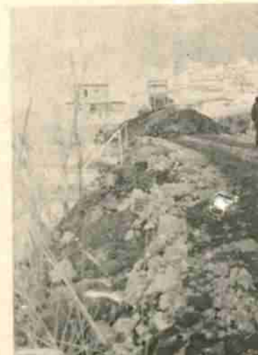
さかんに土砂が運搬され、道路造成中
