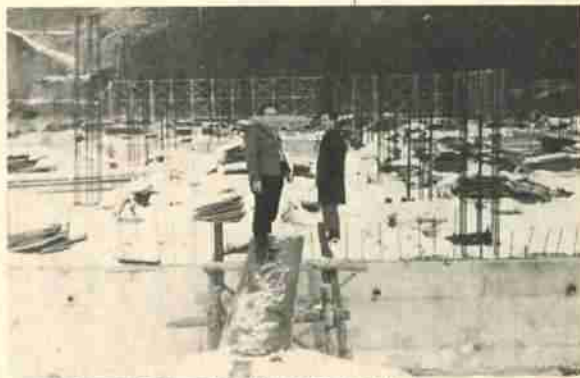
北大病院登別分院の建設現場も視察しました
