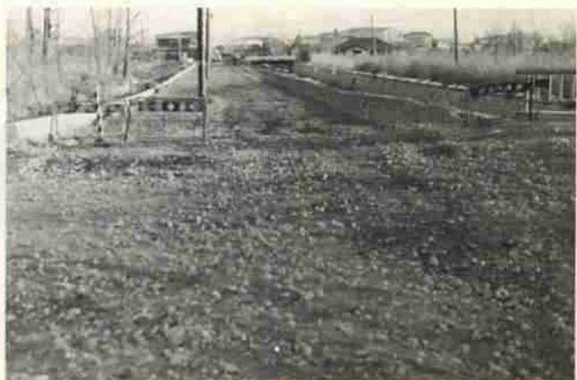
今年の市道舗装は21路線5,389M、総延長27,728M。写真は富岸東線の道路改良工事現場。
