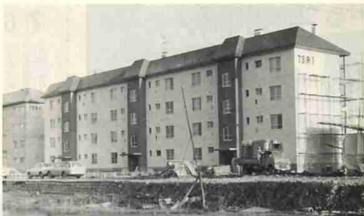
昨年に続いて建設した4階建の市営住宅(3DK、24戸)は工事費6,933万円。東団地のとなりたてられました。また、千代の台団地にも2,395万円で2階建3棟(2DK8戸、3DK4戸)を建設11月30日に完成しています。
