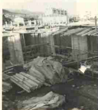
定員120名収容として1億円で建設中の梶別保育所
