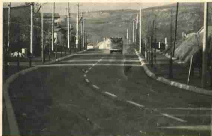
道路舗装5,999.58メートル64,500千円 写真は幌別中学校通り舗装事業
