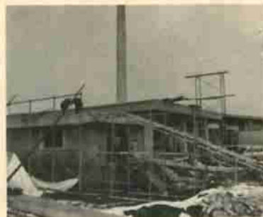
建設中の富浦火葬場 24,120千円
