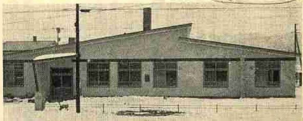
富浜児童館建設工事 補強コンクリートブロック造り 総工事費 500万円 竣工 44年11月15日
