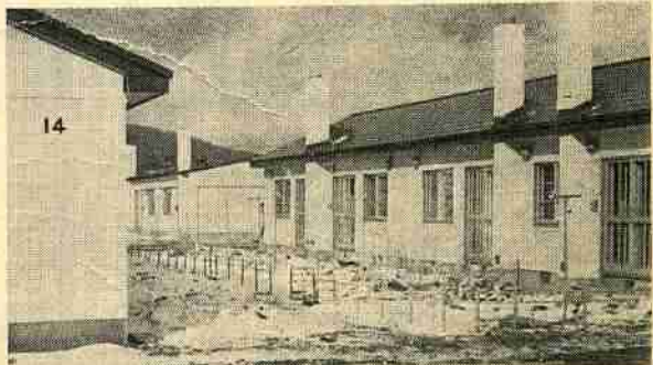
公営住宅建設工事 コンクリートブロック造り 48戸 工事費 4,260万円 竣工 44年12月16日
