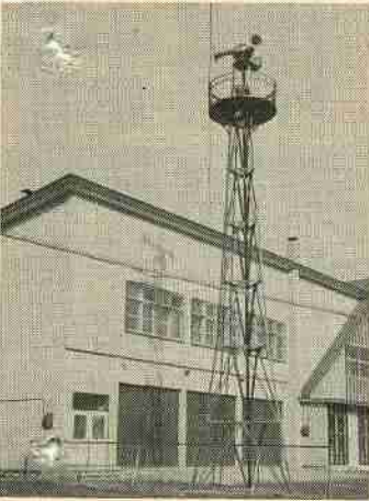
▶ 鷺別消防分遣所 建築工事 竣工 四十三年三月十一日 工費 一、一五〇万円
