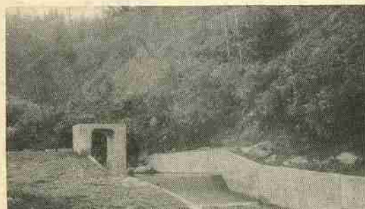
◀札内地区飲雑用水 取水堤工事(二期分) 竣工 四十三年十一月二十二日 工費 九〇二万円
