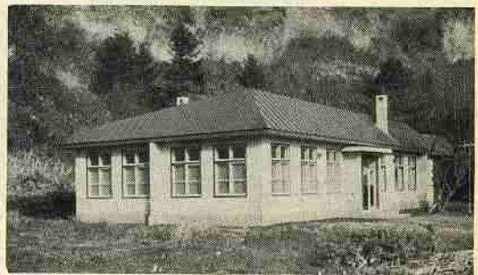
▶ 富浦生活館新築工事 工費 五六〇万円 竣工 四十三年十月三十日
