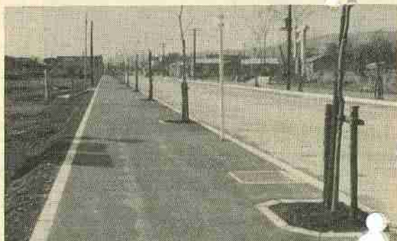
▲舗装工事 中央通外2ヶ所 総工費 1,743万円
