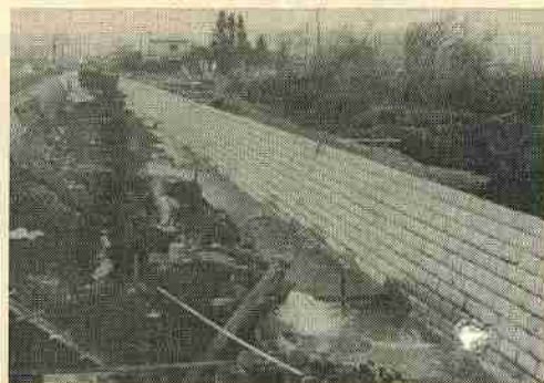
▼災害復旧工事 富岸川災害復旧 外26ヶ所 総工費 4,127万円
