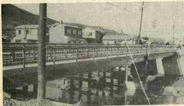
上鷺別高砂橋人道橋新設工事
