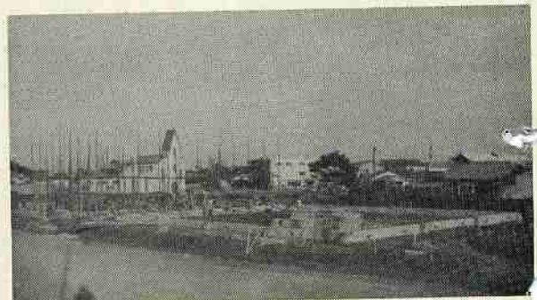
青少年会館の建設工事
