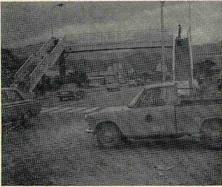
登別中学校前に架設された横断歩道橋
