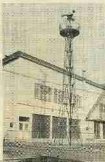
新設した驚別消防分遣所
