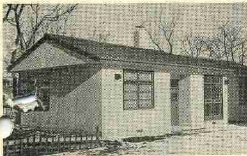
校長住宅新築工事 (鶯別中、幌別小、幌別西小、温泉小・中) 竣工 41年11月28日 総工費 7,725千円
