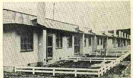
公営住宅新築工事 竣工 41年10月29日 工費 1,322万円
