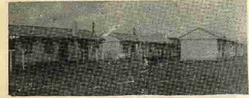
完成した低家賃住宅
