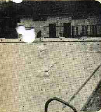
プール新設 竣工 四十年十一月十三日 工費 四二七万円
