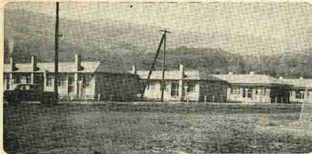
公営住宅新築工事
