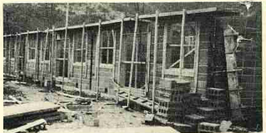
公営住宅建築中
