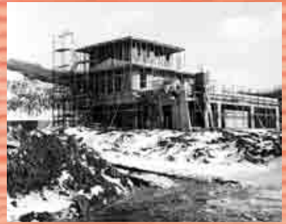
建設中の郷土資料館（昭和56年）
