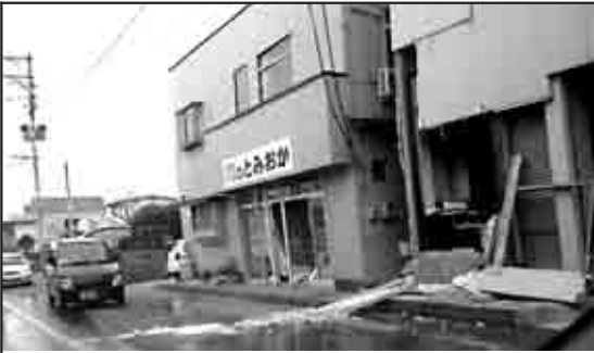
▲建物の一部が損壊した白石市の市街地
