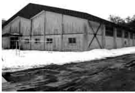
▲耐震補強工事を実施する青葉小学校体育館
