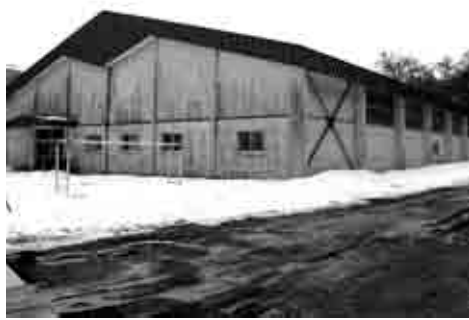
▲耐震補強工事を実施する青葉小学校体育館
