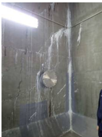
高区配水池の弁室の壁
