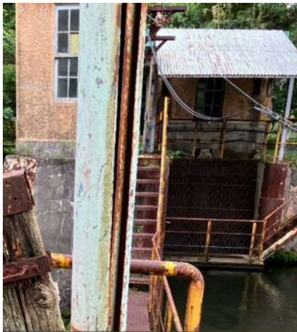
幌別浄水場取水口周辺
