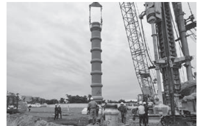
▲杭打ち工事の様子
