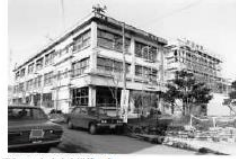
昭和49年本庁舎増築工事
