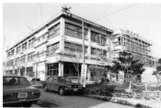
昭和49年本庁舎増築工事
