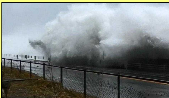
H28.1.18波浪警報 道道登別港線の越波状況
