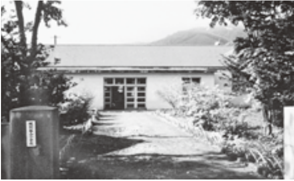
▲建て替え後の幌別鉾山小中学校の新校舎
