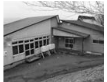
▲鷺別小学校隣接地へ移転改築される鷺別児童館
