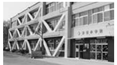
▲耐震化改修工事が終了した青葉小学校
