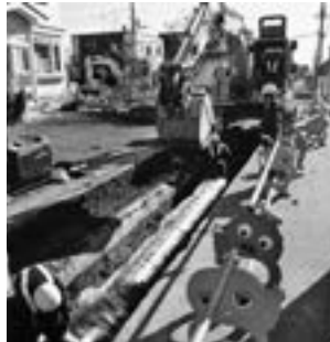
▲道路排水対策（雨水対策）工事
