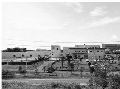
▲下水やし尿などの処理を行う若山浄化センター
