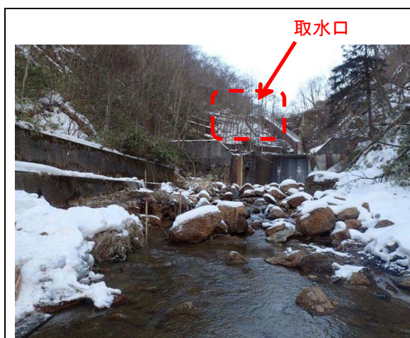
登別温泉浄水場 取水口周辺
