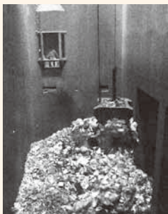
▲クリンクルセンターのごみピット内部
