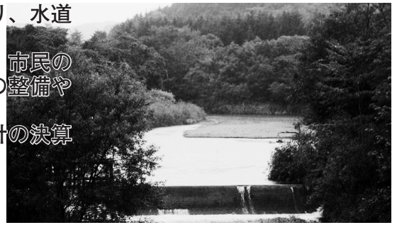
▲幌別浄水場取水口
