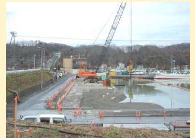
【作業中の旧港区】
