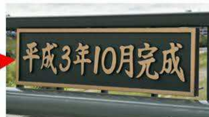
橋名板 （金属製プレート）
